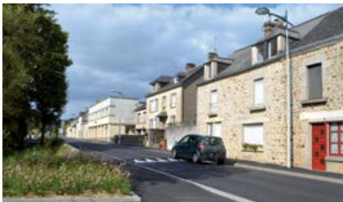
La chaussée moins large et le ralentisseur installé ont permis de réduire la vitesse rue du Petit-Étang.
